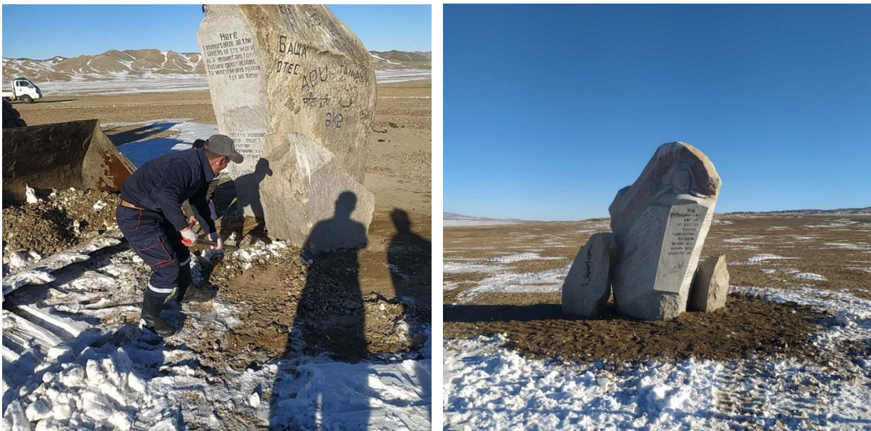
Зураг №8 Аав хөшөөний суурийн хайргыг зөөж, тэгшлэх ажил
