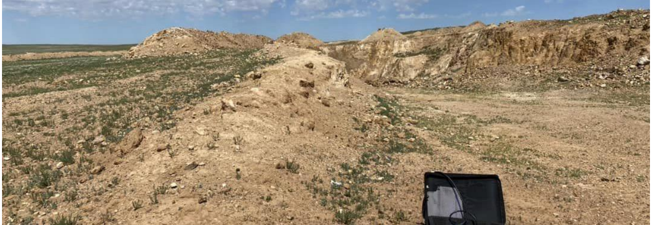
Зураг 3. Талбайд үерийн далан байгуулсан байдал
