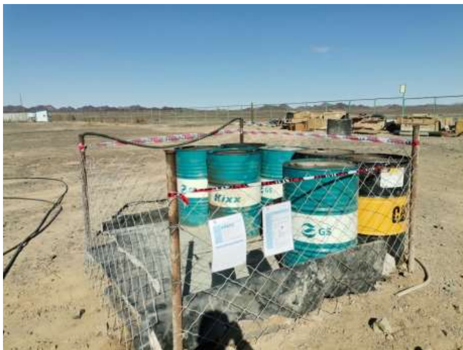
Зураг 57. Шатах тослох материалын хадгалалт, хамгаалалт хийсэн байдал
