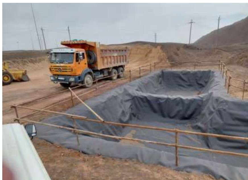
Зураг 28. Өрмийн шингэн хуримтлуулах талбайд мал амьтан орохоос хамгаалж хаалт хашилт хийсэн байдал
