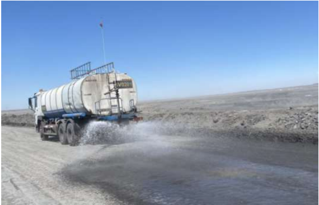
Зураг 23. Зам талбайн тоос дарах усалгаа хийж буй байдал
