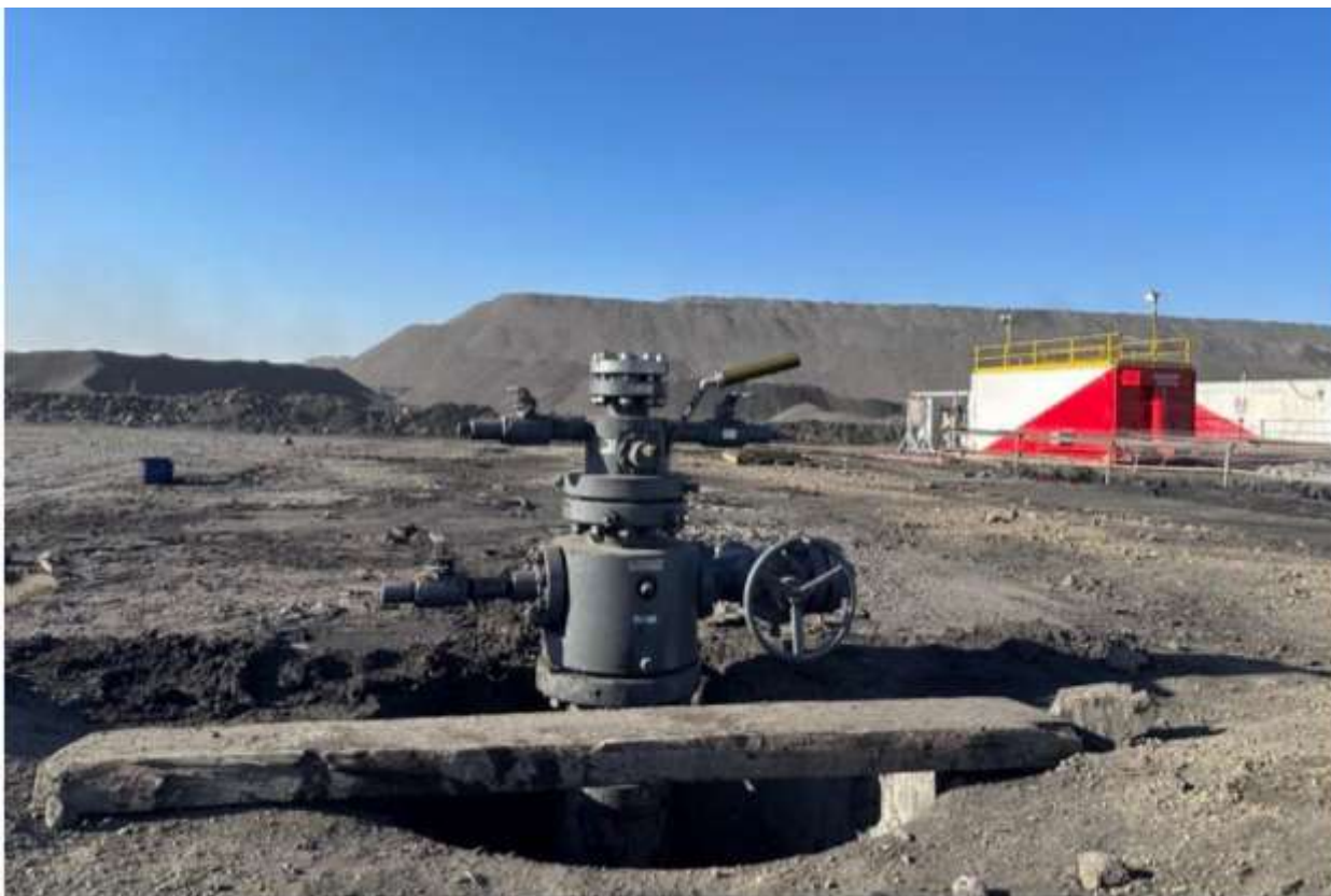
Зураг 8. Цооногийн толгойн амсрын байгууламж, өрөмдлөгийн ажил дууссаны дараах байдал
