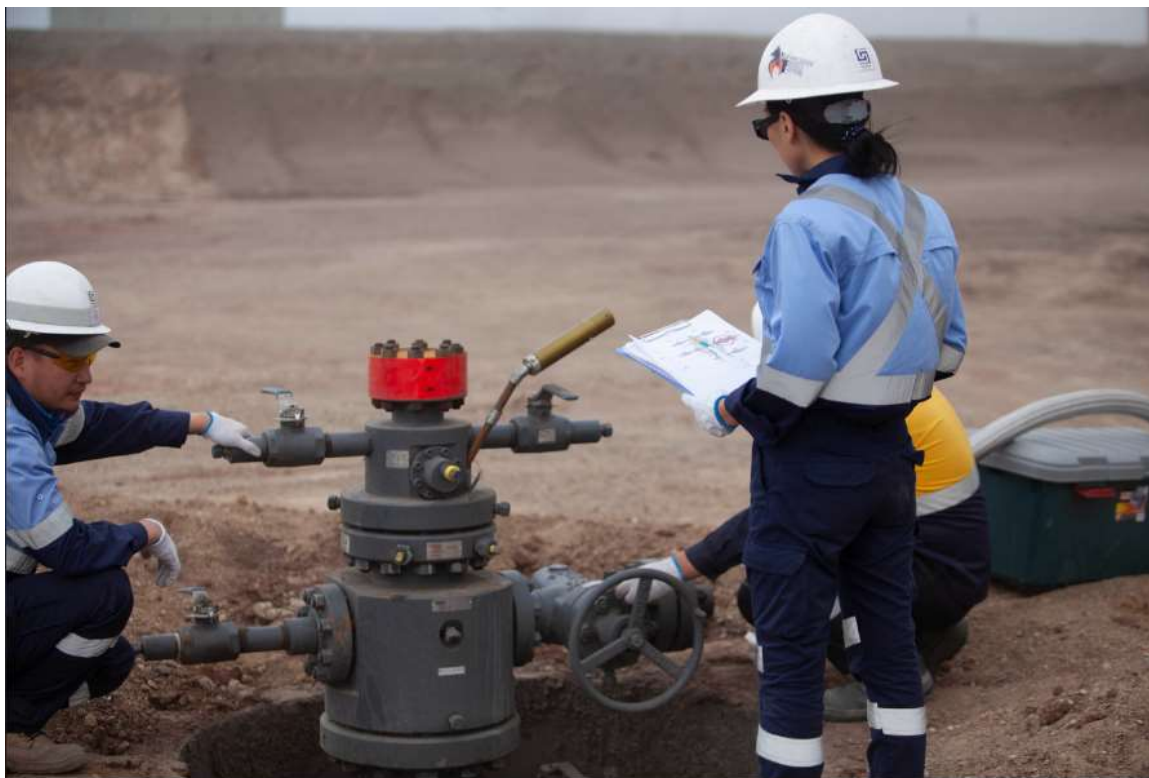
Зураг 40. Туршилт олборлолтын цооногийн амсарыг битүүмжилсэн байдал
