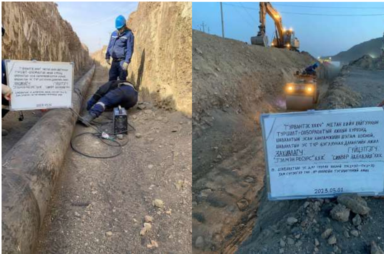
Зураг 14. Туршилт олборлолтын цооногоос шавхагдсан нүүрсний усыг зайлуулах шугам хоолой барилтын явцын зураг
