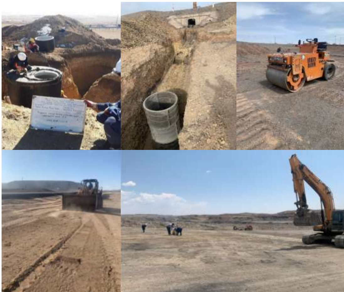
Зураг 43. Шуган хоолойн орчинд тэгшилгээ хийж техникийн нөхөн сэргээлт хийсэн байдал
