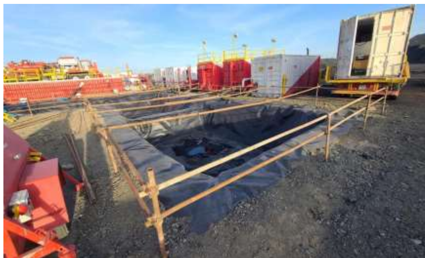
Зураг 27. Өрмийн шингэн хуримтлуулах нүхийг плёнкоор доторлосон байдал
