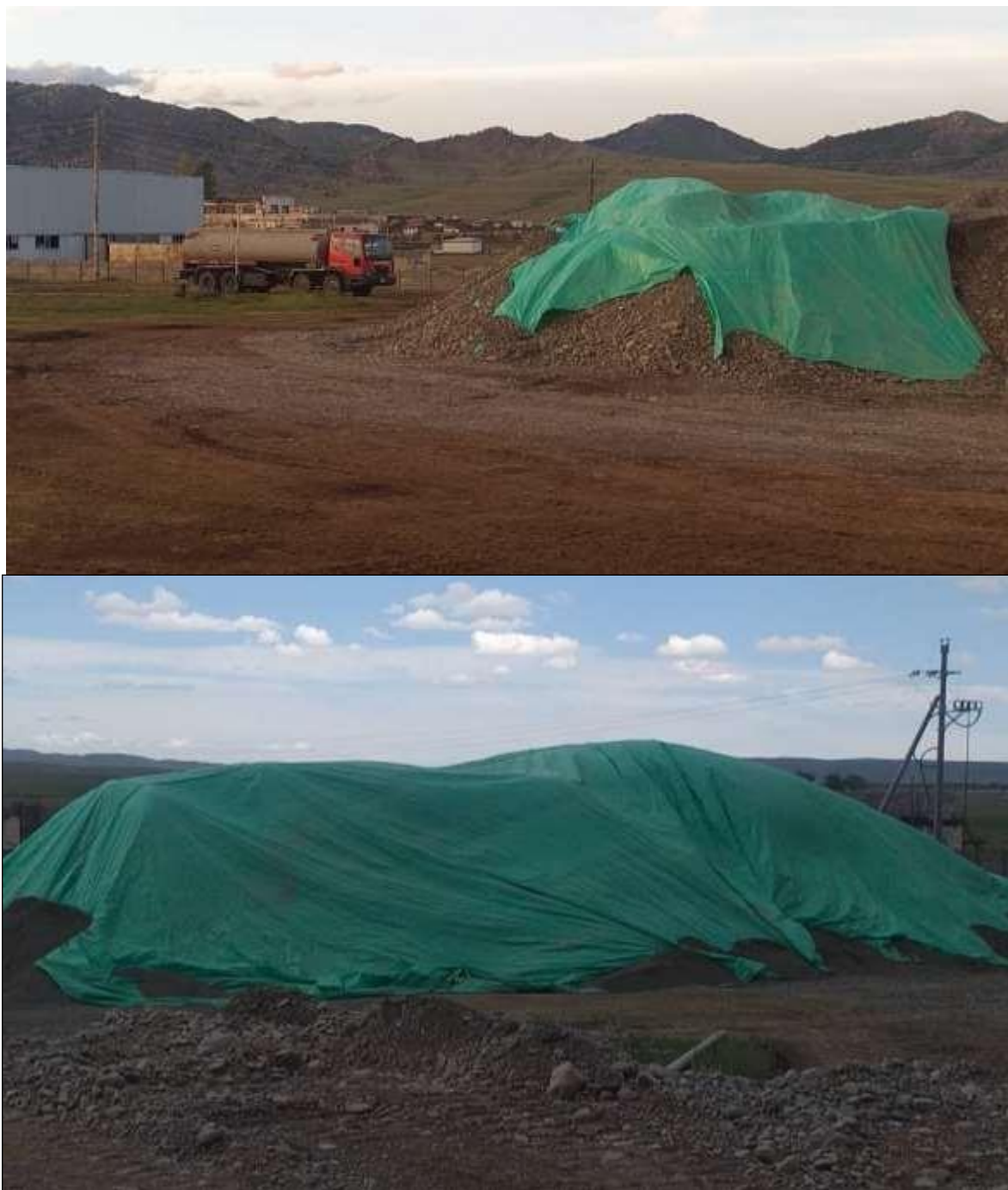
Зураг 10 Тоосжилтийг бууруулах зорилгоор хучилт хийж буй байдал
