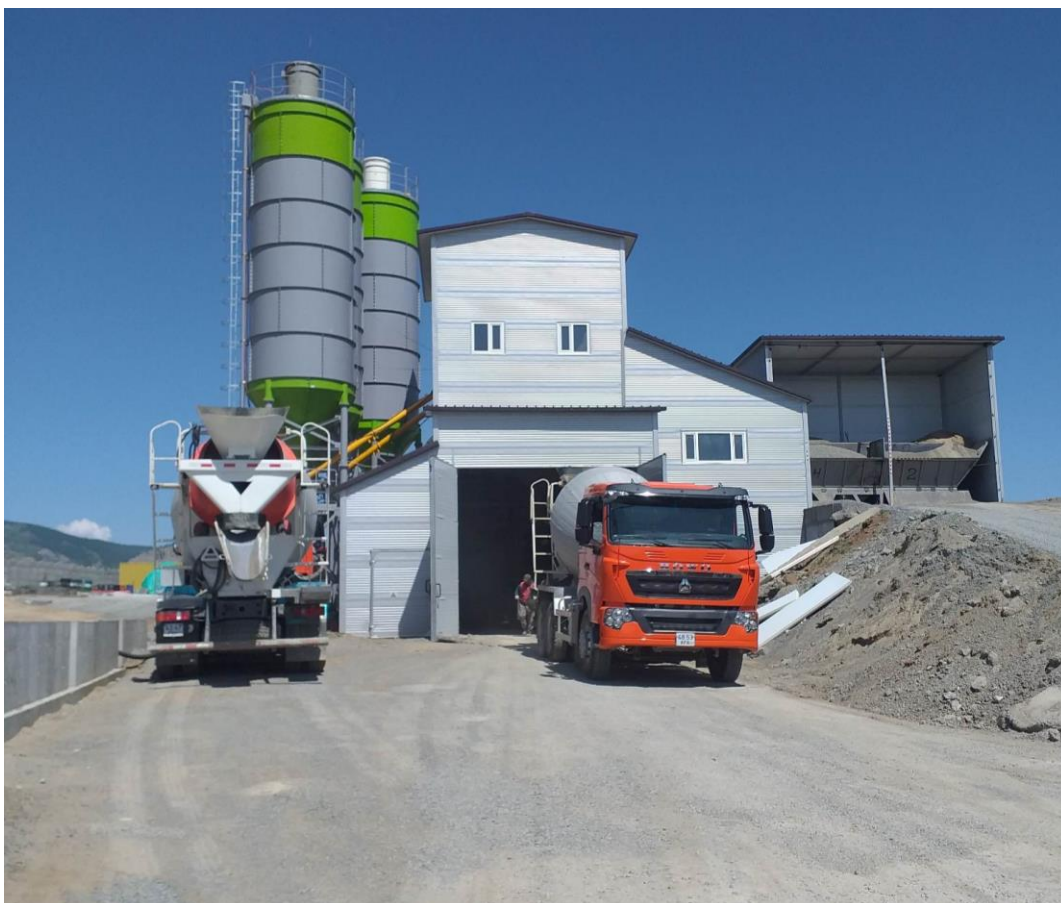
Зураг 3 Бетон зуурмагийн үйлдвэр
