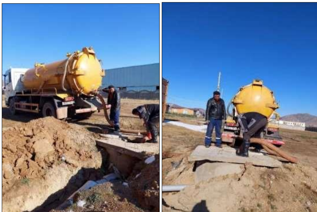
Зураг 15 Ахуйн бохир ус соруулж буй байдал
