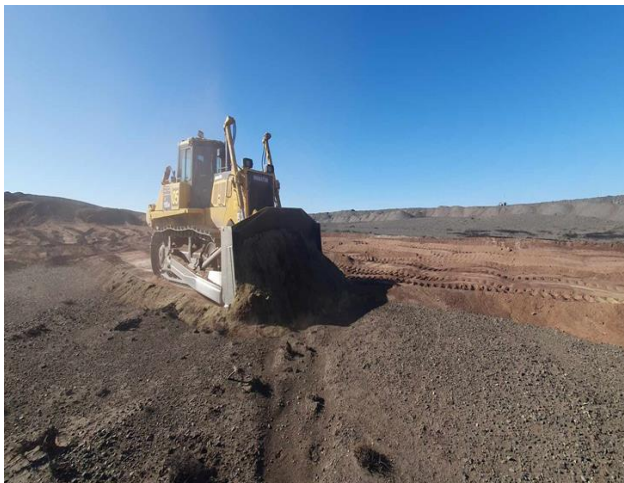
Зураг 21,22 Овоолгын ахилтын талбайд шимт хөрс хуулах явц
