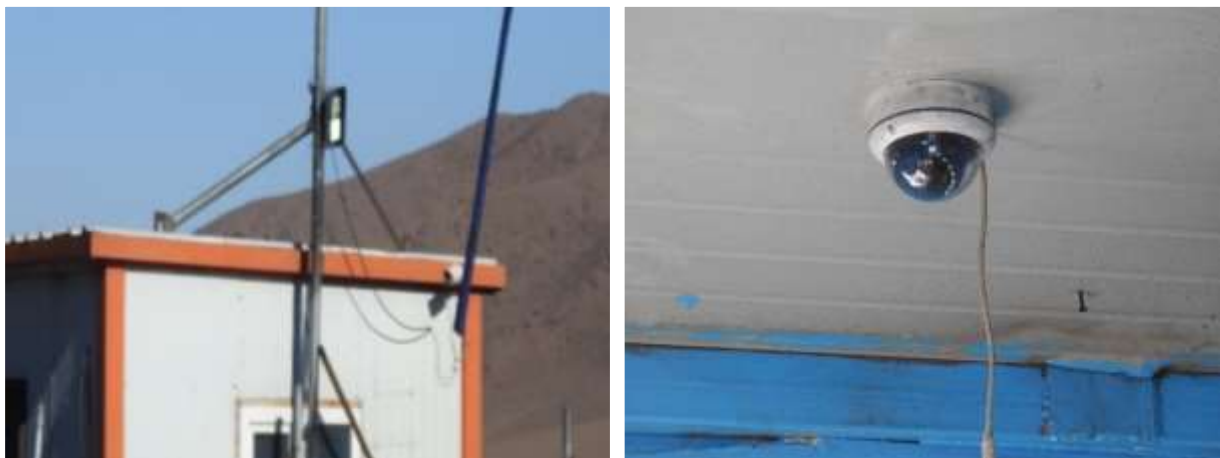
Зураг 6. Худагт суурилуулсан ус ашиглалтын хяналтын камер
