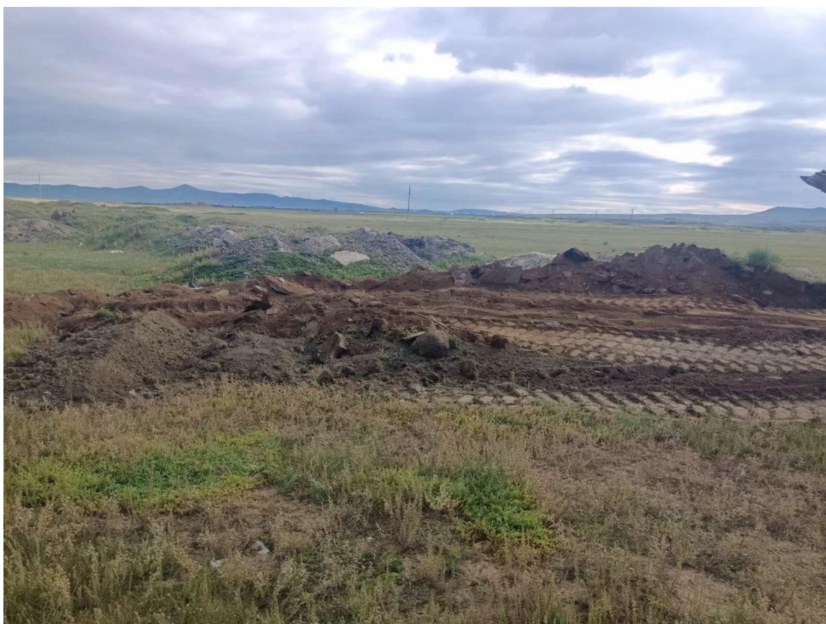
Зураг 4. Нөхөн сэргээлт хийгдэж буй байдал
