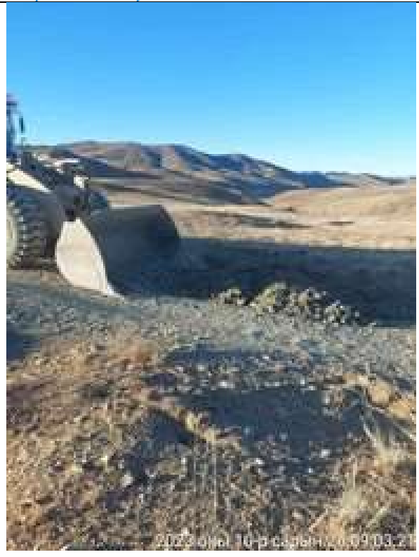
Зураг 37. Уурхайгаас Бөмбөгөр орох замд үүссэн замын эвдрэлийг тэгшилж буй нь
