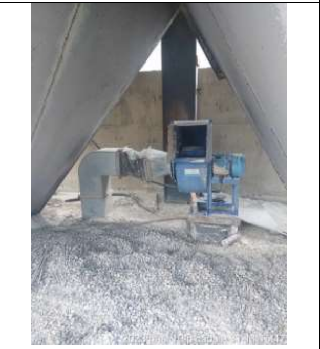
Зураг 48. Баяжуулах үйлдвэрийн агааржуулалтыг шалгасан байдал
