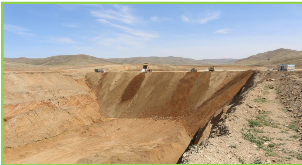
Зураг №3 Хөрс хуулалтын ажил Дотоод овоолгоор дүүргэлт хийж байна.
