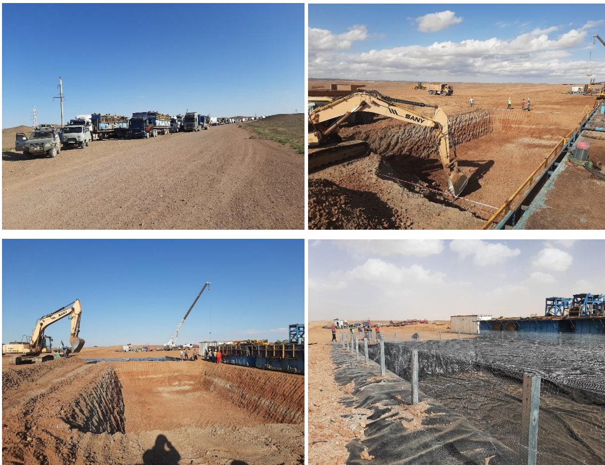
Зураг 8. Өрмийн тоног төхөөрөмжийн тээвэр болон шингэн хаягдлын сангийн доторлогоо Ургамлын бүрхэвч, амьтны аймагт үзүүлэх сөрөг нөлөөллийг бууруулах чиглэлээр хийсэн ажлууд:
