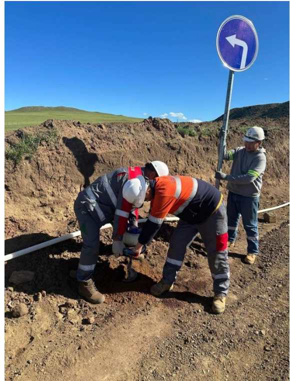
Зураг4. Замын тэмдэг тэмдэглэгээ
