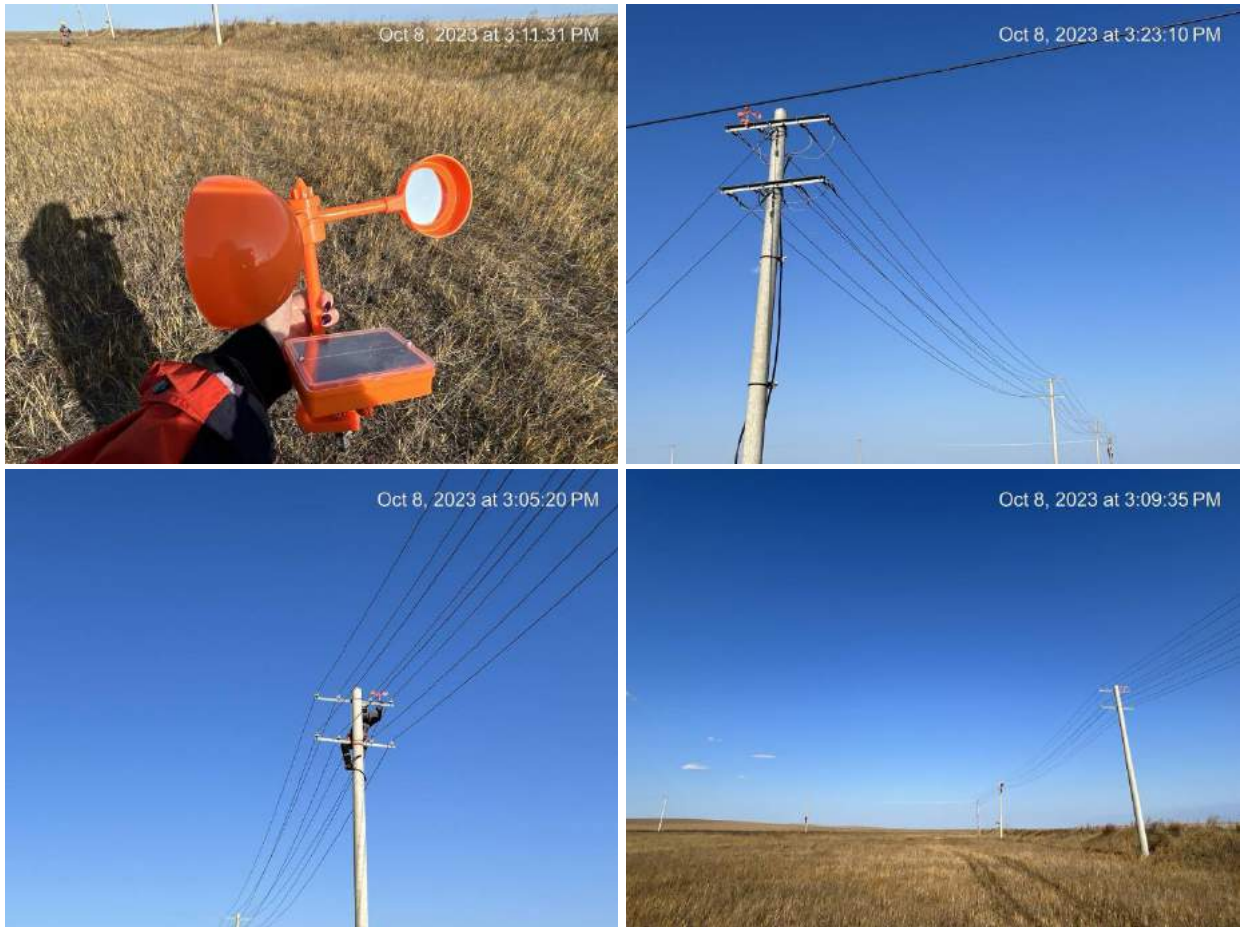
Зураг 61. Шувуу үргээгч толь суурилуулсан байдал
