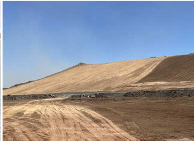
Зураг 32 Хаягдлын гадаад овоолгод техникийн нөхөн сэргээлт хийж, шимт хөрсөөр хучих явц
