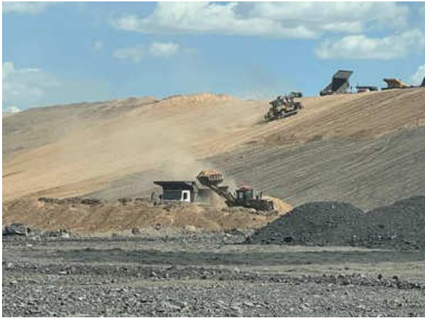
Зураг 32 Хаягдлын гадаад овоолгод техникийн нөхөн сэргээлт хийж, шимт хөрсөөр хучих явц
