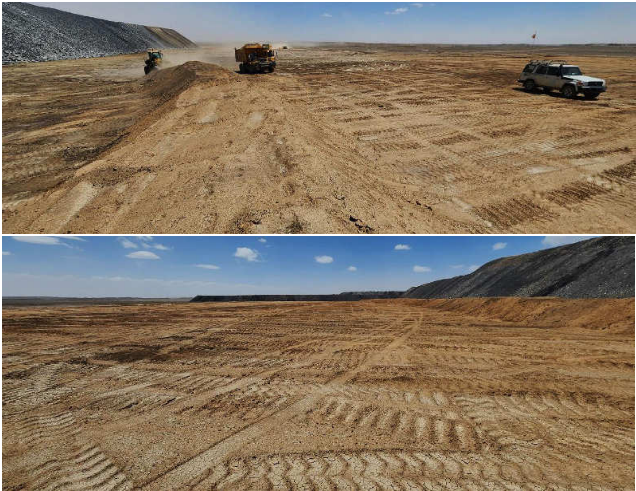
Зураг 21 Шимт хөрс хуулж, ачиж тээвэрлэн өнгөн хөрсний овоолго үүсгэсэн
