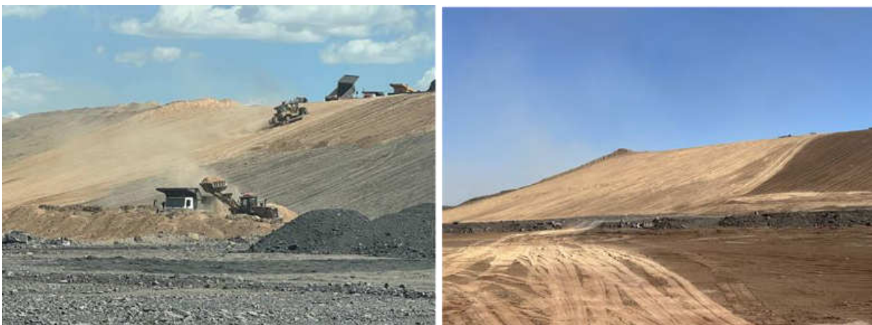
Зураг 18 Хаягдлын овоолгод техникийн нөхөн сэргээлт хийсэн талбайг шимт хөрсөөр хучих явц
