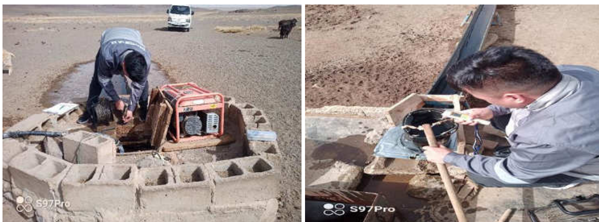
Зураг 58 Худгийн түвшний хэмжилт, pH үзүүлэлтийг хэмжих явц
