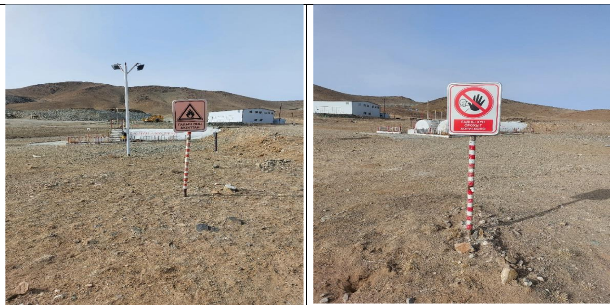
Зураг 10. Шатахуун түгээх станц
