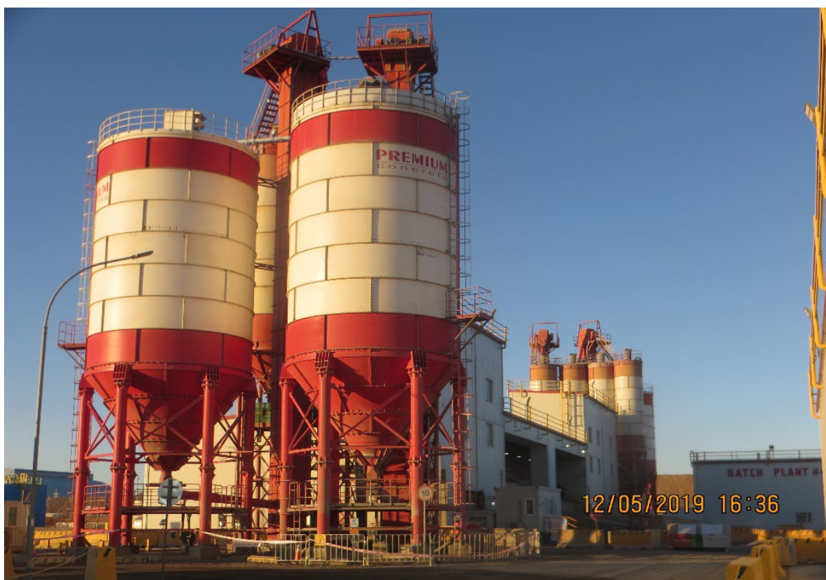
Зураг 19. Бетон зуурмагийн үйлдвэр
