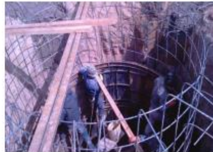
Зураг 2. Босоо ам нэвтрэлтийн үеийн нэвтрэлтийн тавцан Тус ордын босоо амуудын бүтээн байгуулалтын ажлыг 2011-2013 онд гүйцэтгэсэн.
