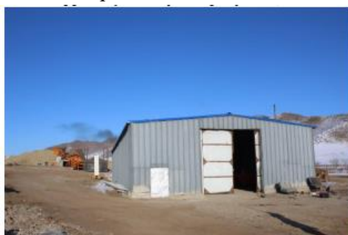
Баяжуулах үйлдвэрийн барилга /урт-24м, өргөн-12м, өндөр-5м/
