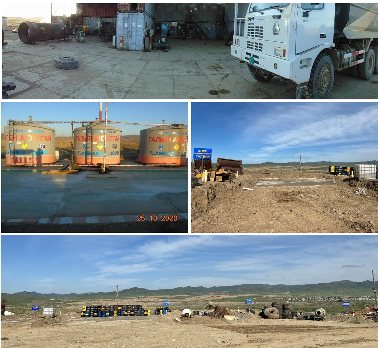
Зураг № 6. Засварын талбай, шатахуун түр хадгалах цэг, хөрс саармагжуулах талбай
