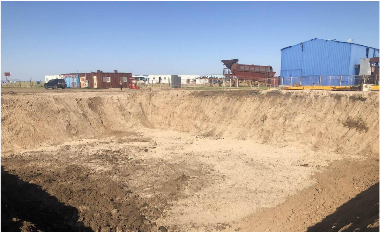
Зураг 5. Тосоор бохирдсон шороо хадгалж байсан сангийн шороог угааж цэвэршүүлэн сулалсан байдал
