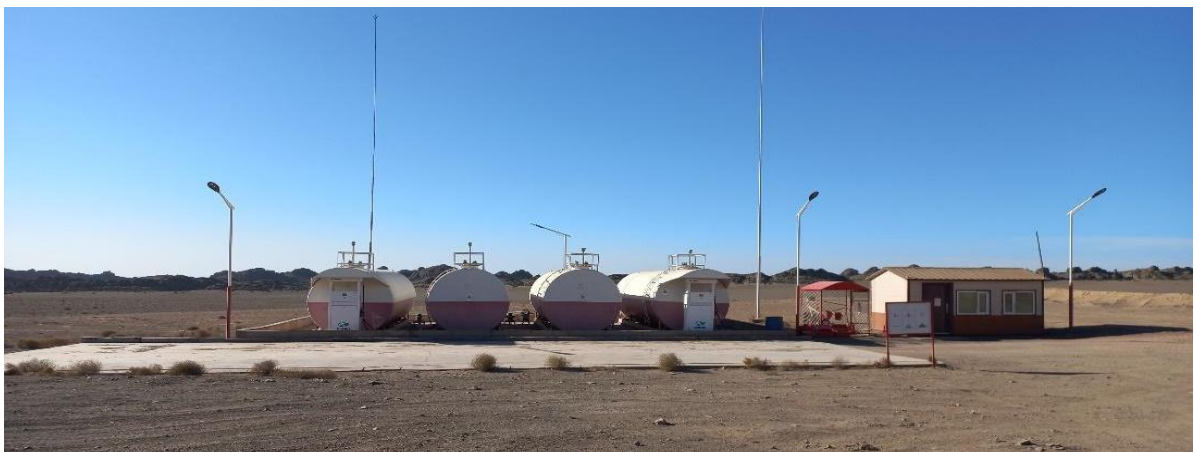
Зураг 10. Шатахуун түгээх станц
