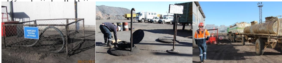
Зураг 10.2.2. Засварын төвүүдийн хаягдал тос цуглуулах танкнуу
