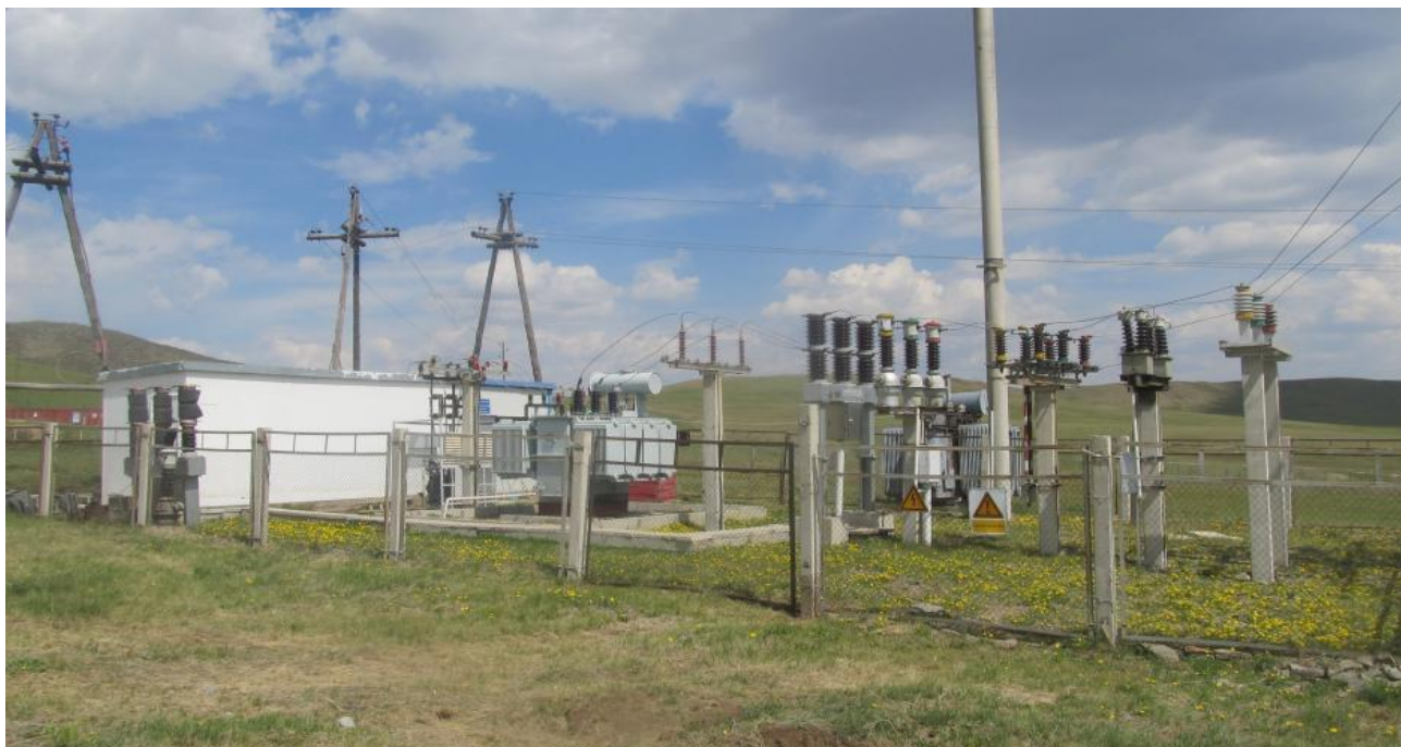
Зураг 7. Уурхайн дэд станц оролтын шугамын хүчин чадал (35000V)
