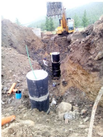
Бүх хүзүү хоолойг битумдэж хөрсний ус нэвчилтээс хамгаалсан.
