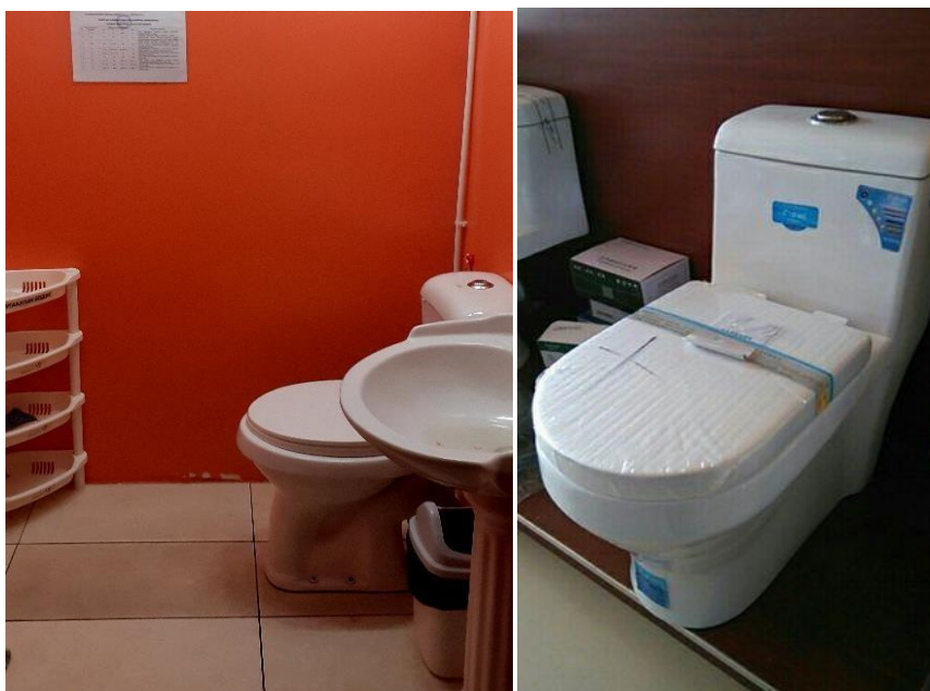
Зураг 3. Ариун цэврийн өрөөний бочкинд усны зарцуулалтыг их болон бага хувилбараар сонгох хос даралтат товчлуур суурилуулсан
