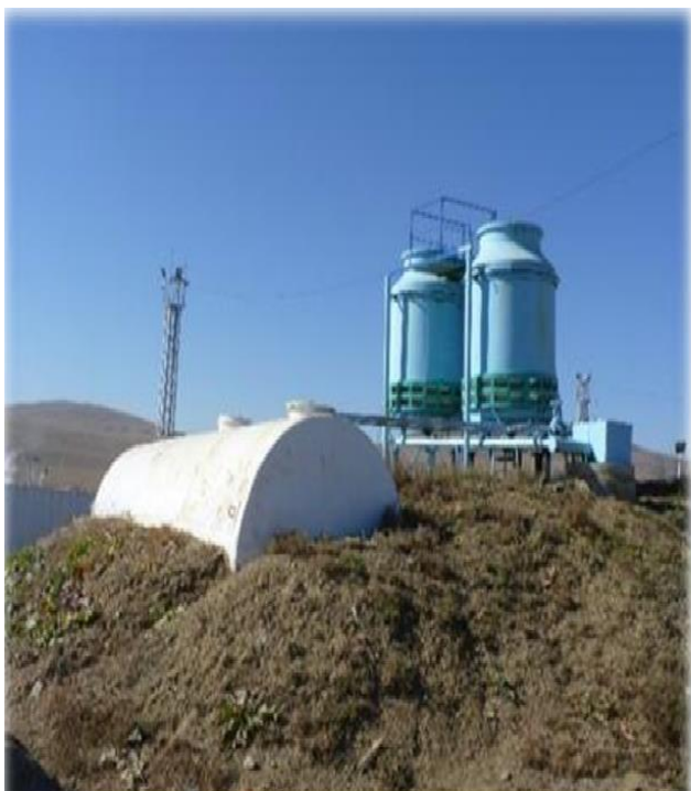
Үйлдвэрийн эргэлтийн усны сав, багтаамж - 200 м3
