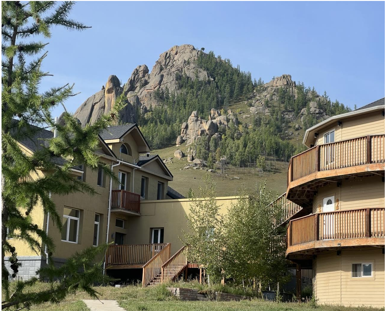
Зураг № 2. 2 давхар термоблок бетонон барилга
