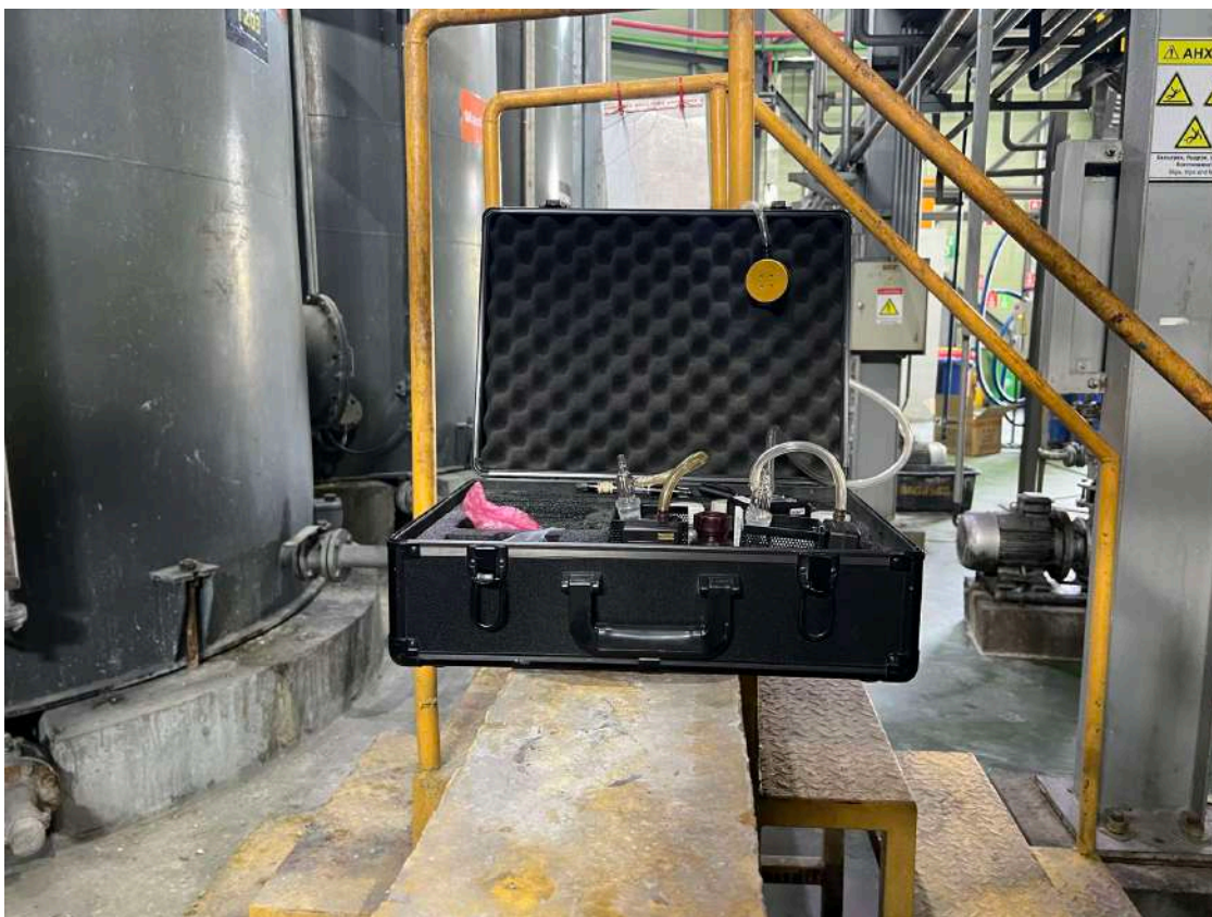
Зураг 21. Агаарын цэг-1. /Бетон нэмэлтийн үйлдвэр дотор/
