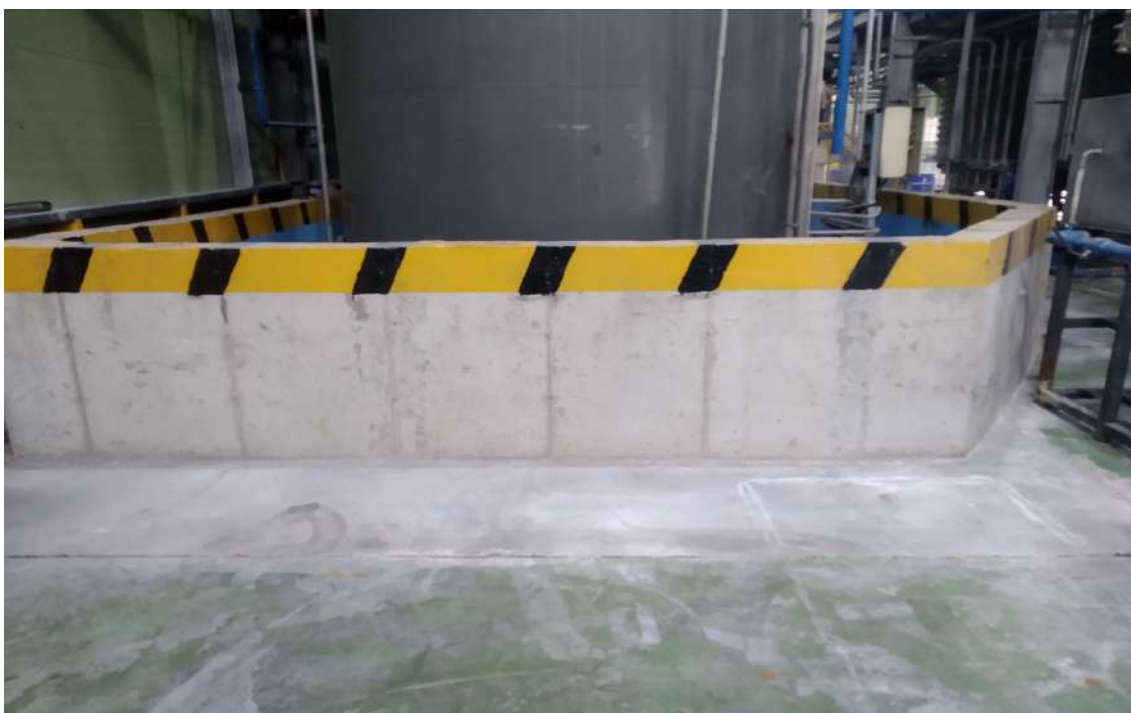
Зураг 4. Бетон нэмэлтийн үйлдвэрийн бүтээгдэхүүн асгарахаас сэргийлсэн хантай.
