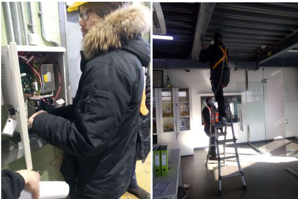
Зураг 12. Галын дохиоллын үзлэг шалгалтыг хийж байна
