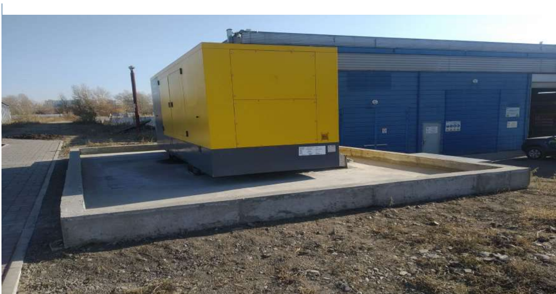
Зураг 3. Генераторын хөрсөнд тос асгарахаас сэргийлсэн суурьтай.
