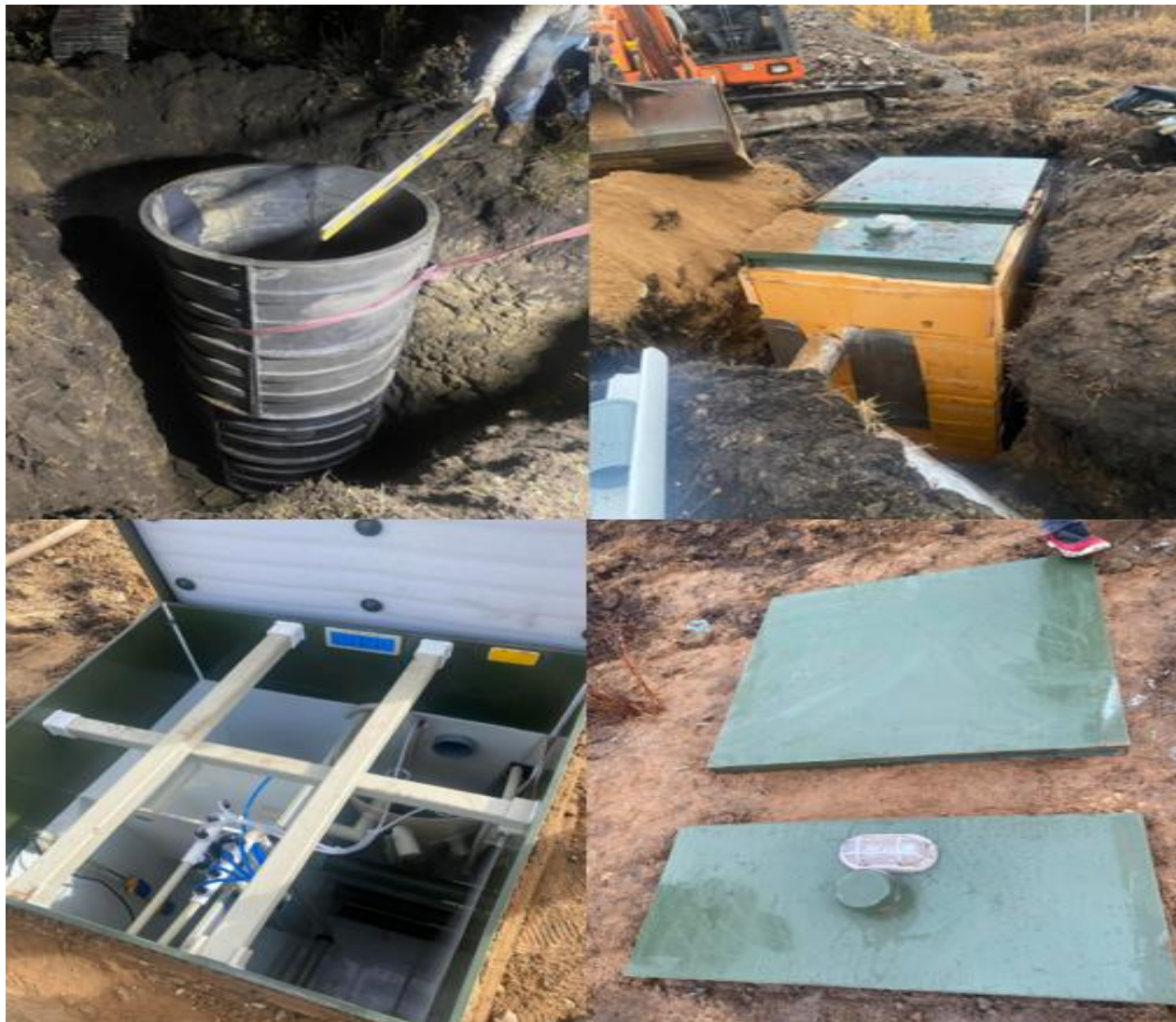
Зураг 7 Суурилуулалтын үеийн байдал
