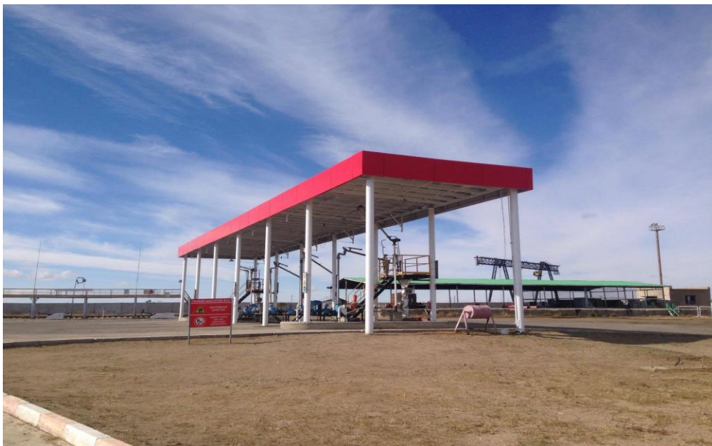
/Зураг-1 Агуулахын ачих АСН-5 бетонон талбай/
