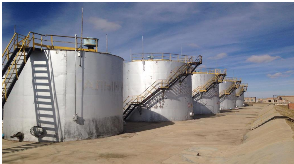
/Зураг-2 Газрын тосны бүтээгдэхүүний агуулах дээр босоо цилиндр ган савнууд суурилуулсан байдал сав паркийн далан/
