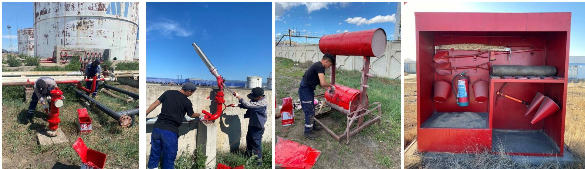
Зураг.9 Аюул эрсдэлдийн бэлэн байдлыг хангах үүднээс галын багаж хэрэгслийг бүрэн шинчилж, гаднах өнгө үзэмжийг сэргээсэн
