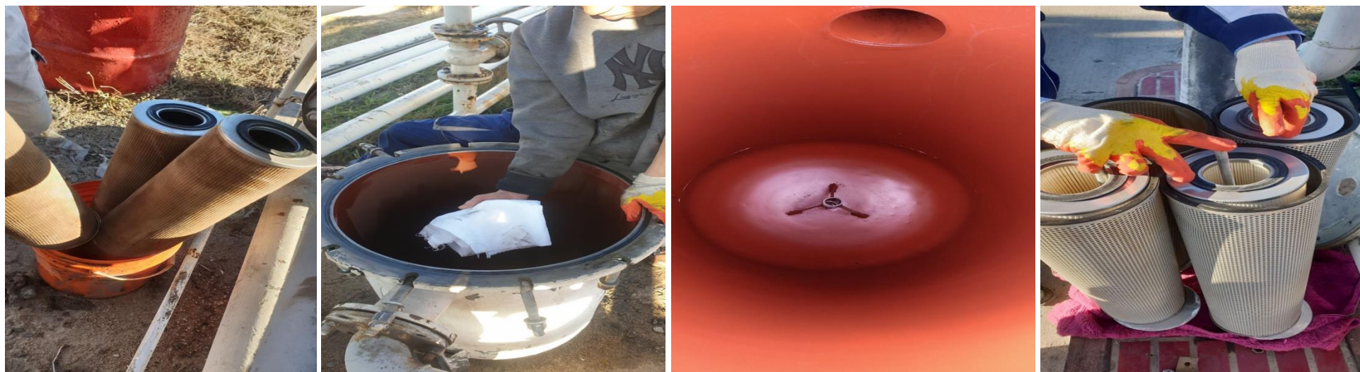
Зураг.13 Босоо савнаас шатахуун ачих завсрын шугам хоолойн коллекторын шүүрийг бүрэн шинэчилж шинээр сольсон
