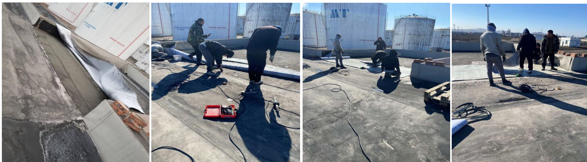
Зураг.17 Агуулахын цахилгаан шитны байрны хууларсан дээврийг засварлаж ус гоожих аюулаас урьдчилан сэргийлсэн
