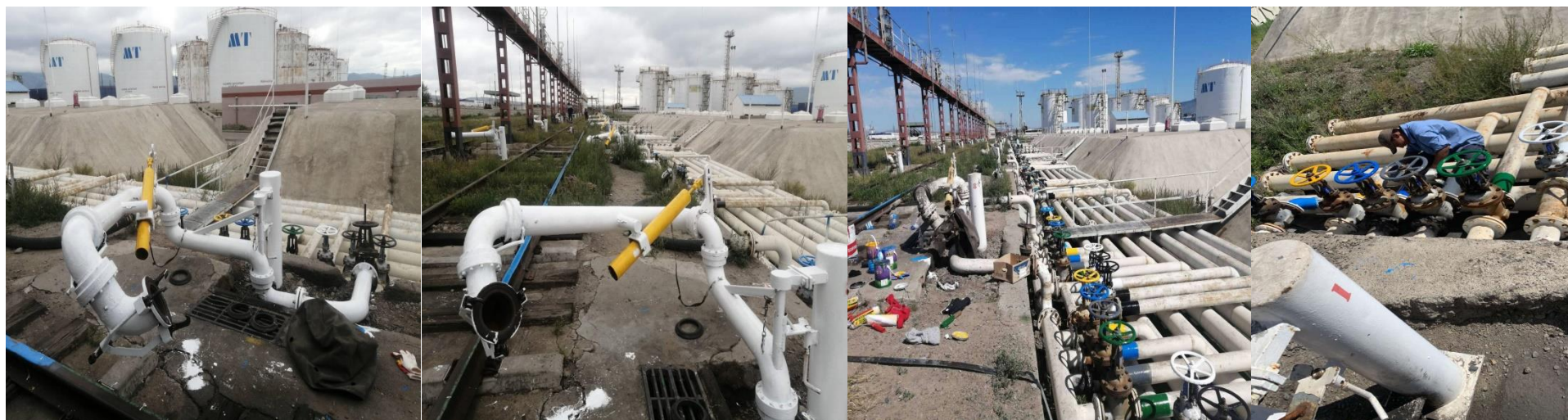
Зураг.11 Технологийн шугам хоолой болон эд ангиудын насжилтыг нэмэгдүүлэх өнгө үзэмж сайжруулах бүдгийн ажил
