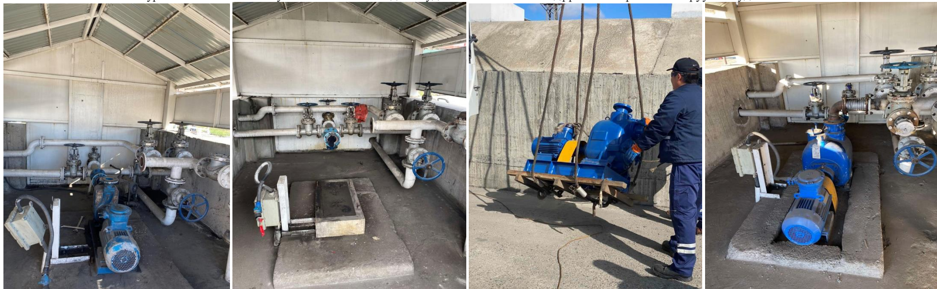
Зураг.12 Хэвтээ саванд шатахуун авах 3 насосыг вакум насосоор сольж агаарын бохирдол багасгаж, насосны битүүмжлэлийг сайжруулав
