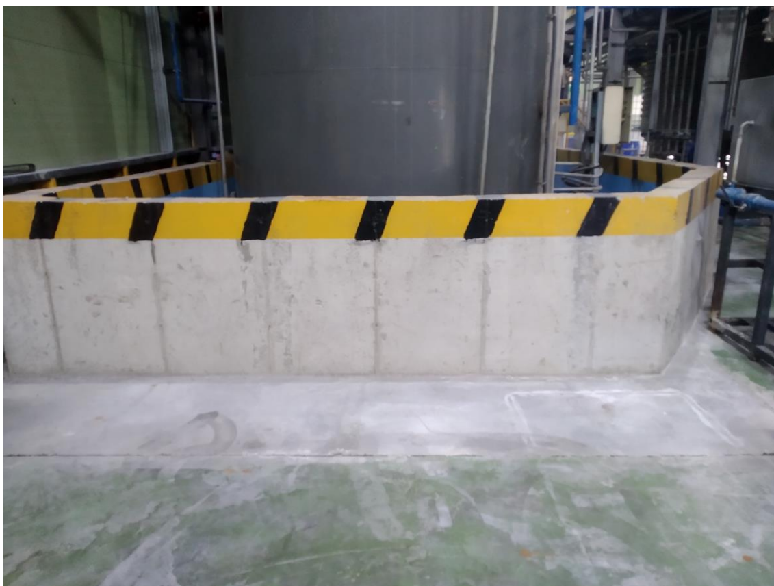
Зураг 4. Бетон нэмэлтийн үйлдвэрийн асгаралтын хана.
