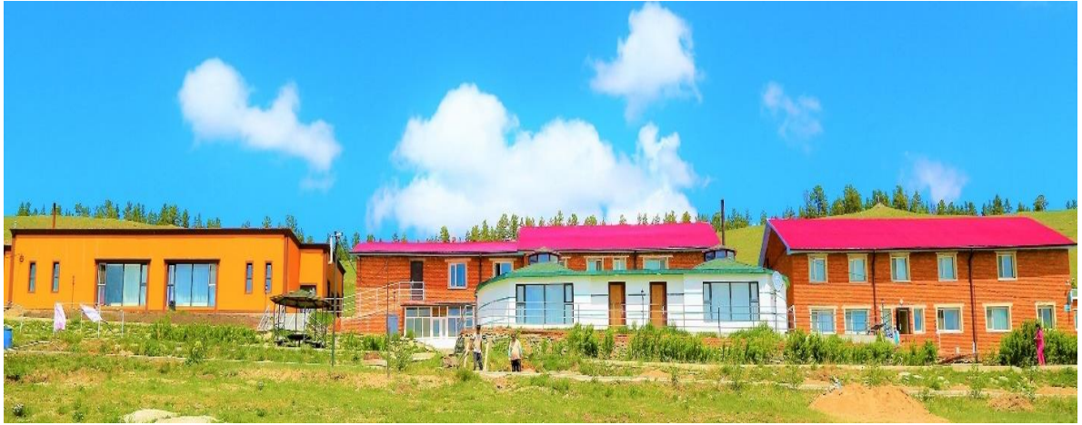
Зураг 8. Төслийн талбайн фото зураг
