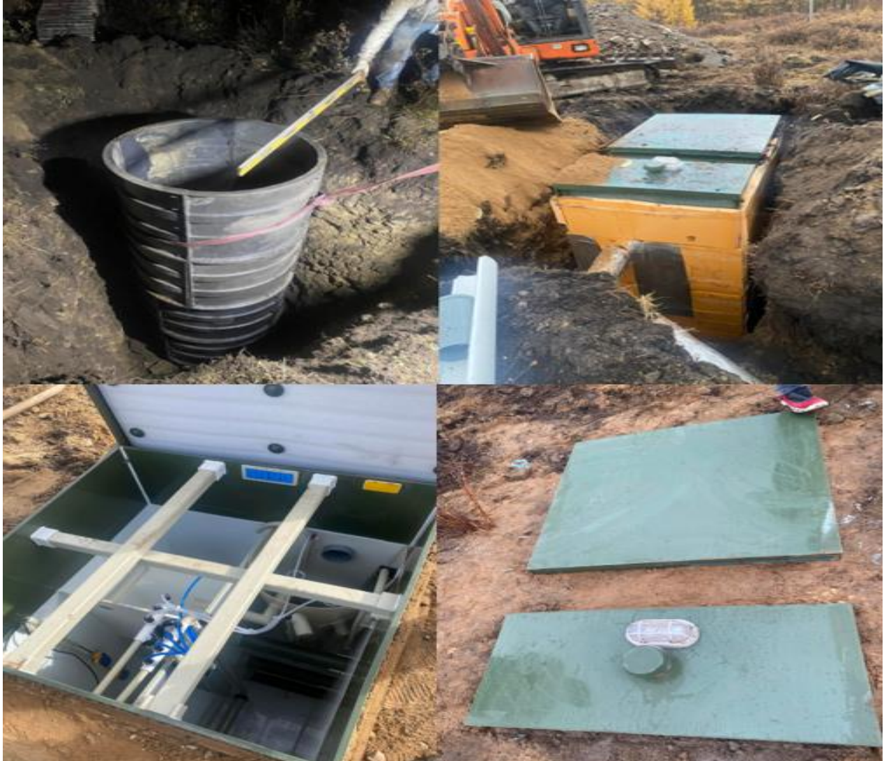
Зураг 7 Суурилуулалтын үеийн байдал
