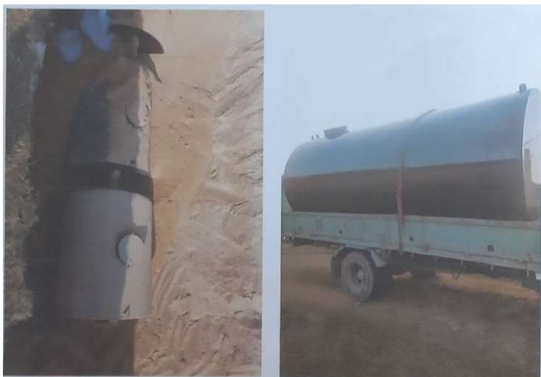
Зураг 7. Цэвэрлэх байгууламж хийж буй зураг
