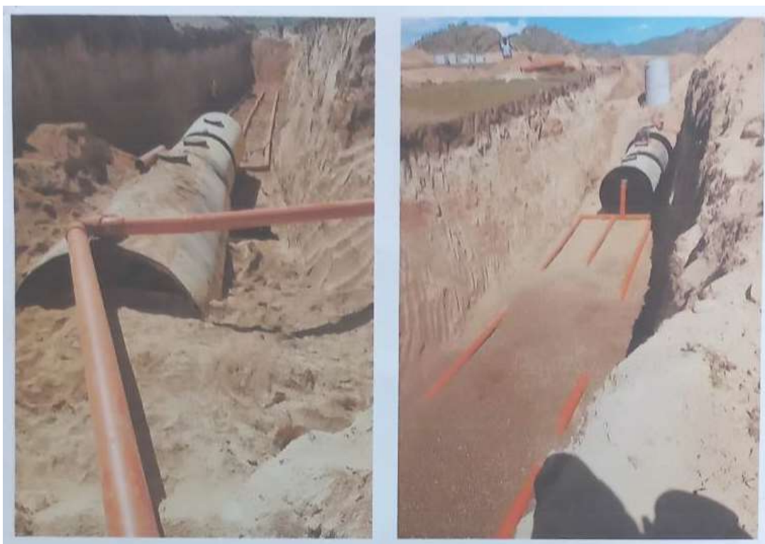
Зураг 6. Бохир усны систем суурилж буй зураг
