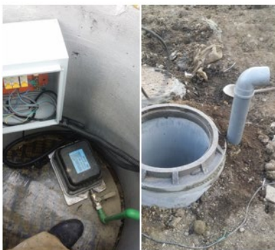
Тусгайлан агааржуулалттай худаг гаргаж агаарын шахуурга, цахилгааны самбар угсарч байрлуулсан. Агаарын шахуурга 120 л/мин хүчин чадалтай.
