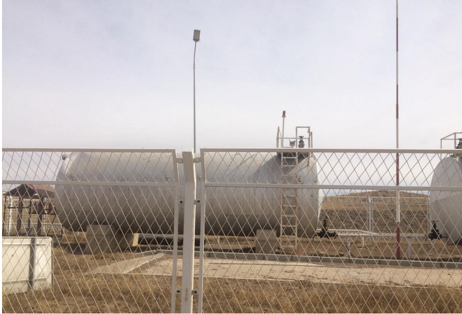
Зураг 1. Төслийн хашаан дахь барилга байгууламжууд
