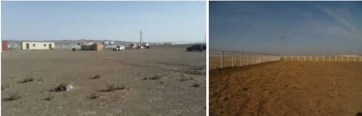
Зураг 1. Төслийн хашаан дахь барилга байгууламжүүд
