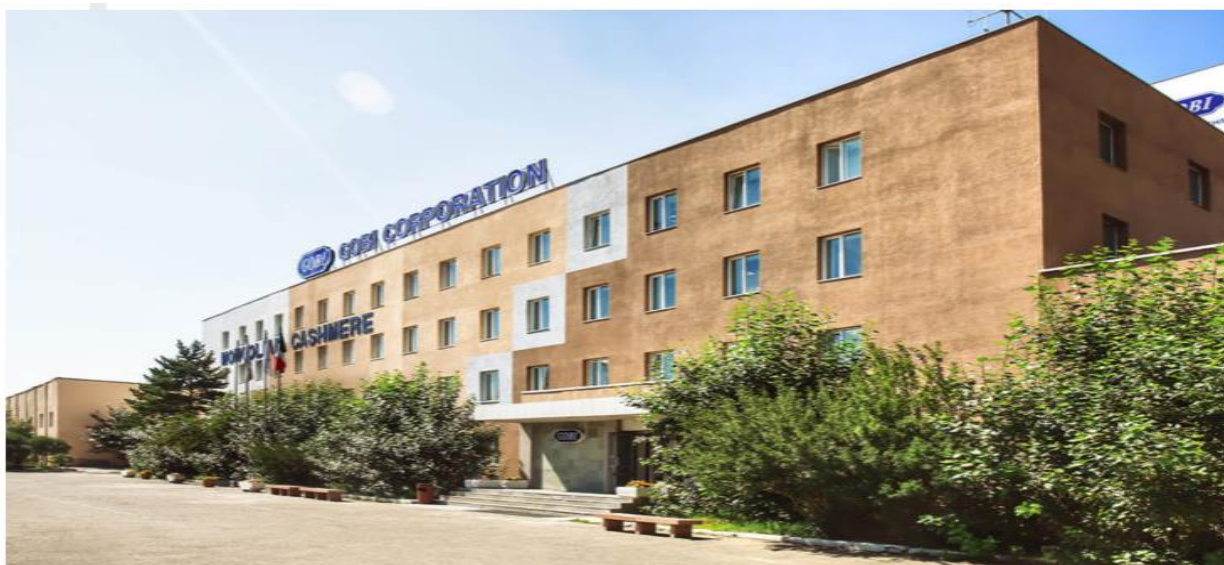
Зураг.2 Говь ХК-ийн үйлдвэрийн байр
