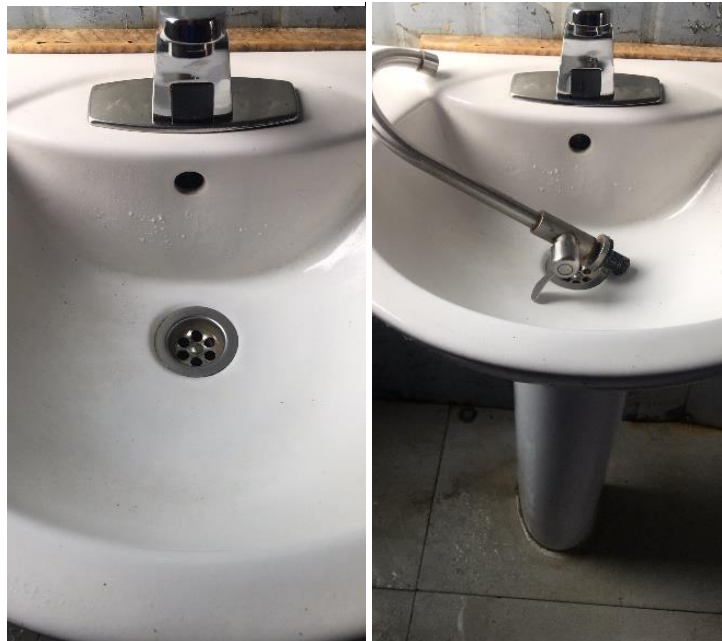
Зураг № 5 Мэдрэгчтэй холигч байрлуулсан зураг
