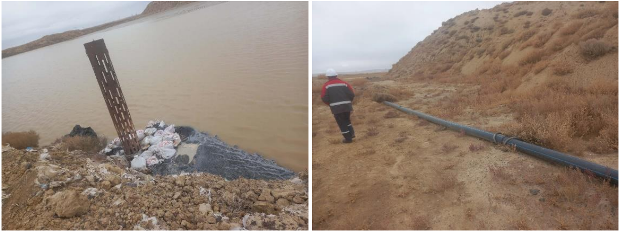
Зураг №8 Хаягдлын далангийн үзлэг хийж байгаа байдал
