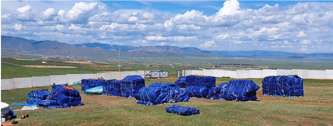
Зураг 7. Барилгын угсрлаланд ашигдах материалыг бүтээсэн байдал
