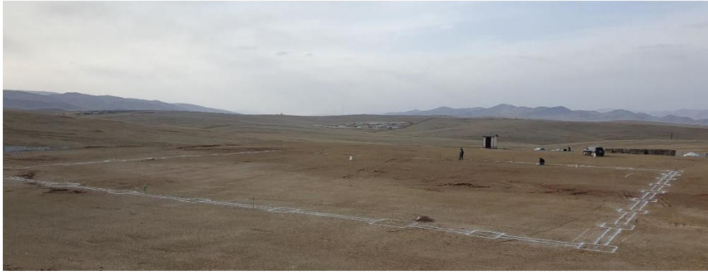
Зураг 9. Суурь ухахын өмнө геодезийн хэмжилт хийж төлөвлөсөн байдал
