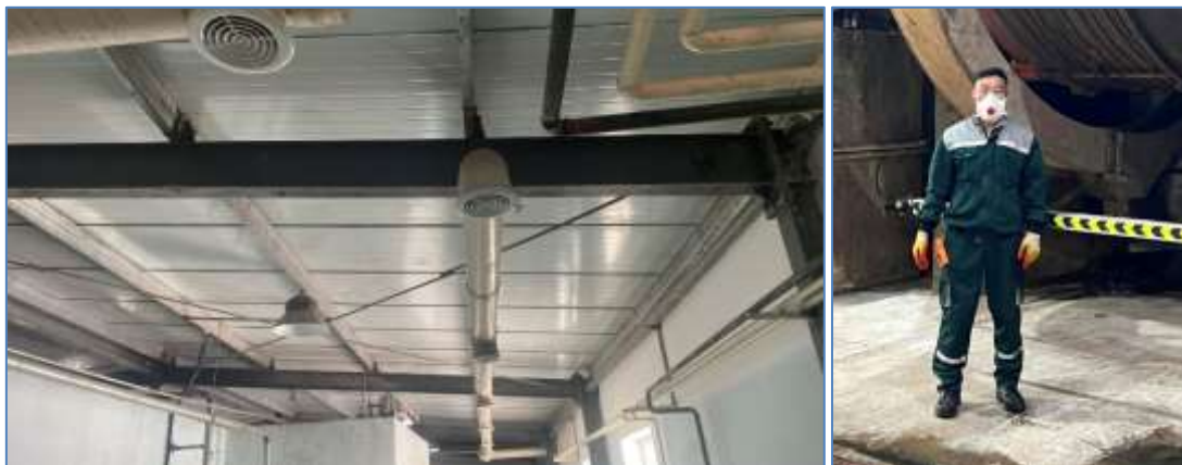
Зураг 4. Үйлдвэрийн агааржуулалтын систем, ажилчдыг хошуувчаар хангасан байдал
