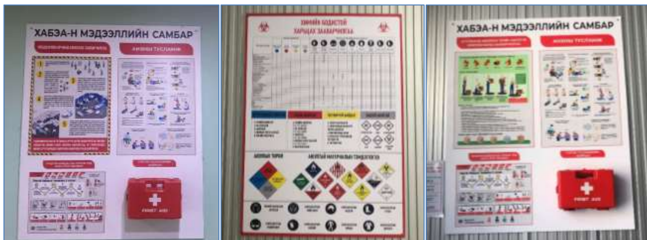
Зураг 19. Химийн бодистой харьцдаг ажилчдад ХАБЭА-н ажилтан тогтмол хянаж ажилладаг. Үйлдвэр, агуулах дээр химийн бодистой харьцах зааварчилгааны самбар, анхан тусламжийн эмийн сан, химийн бодисын асгаралтын үед ашиглах багаж хэрэслүүдийг байрлуулсан байна.
