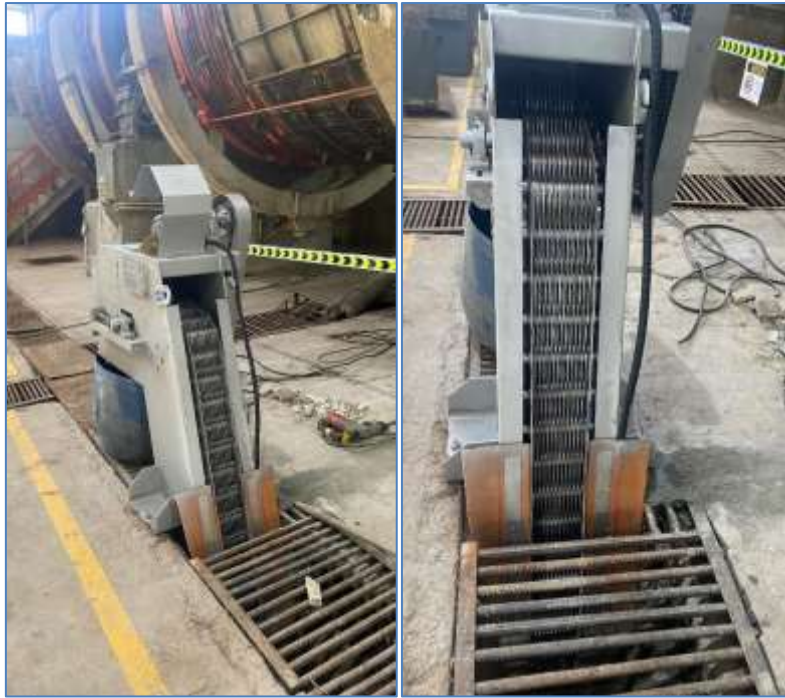
Зураг 10. Үйлдвэрээс гарах бохир усыг урьдчилан цэвэрлэх байгууламж / механик сараалж/ суурилуулсан байдал
