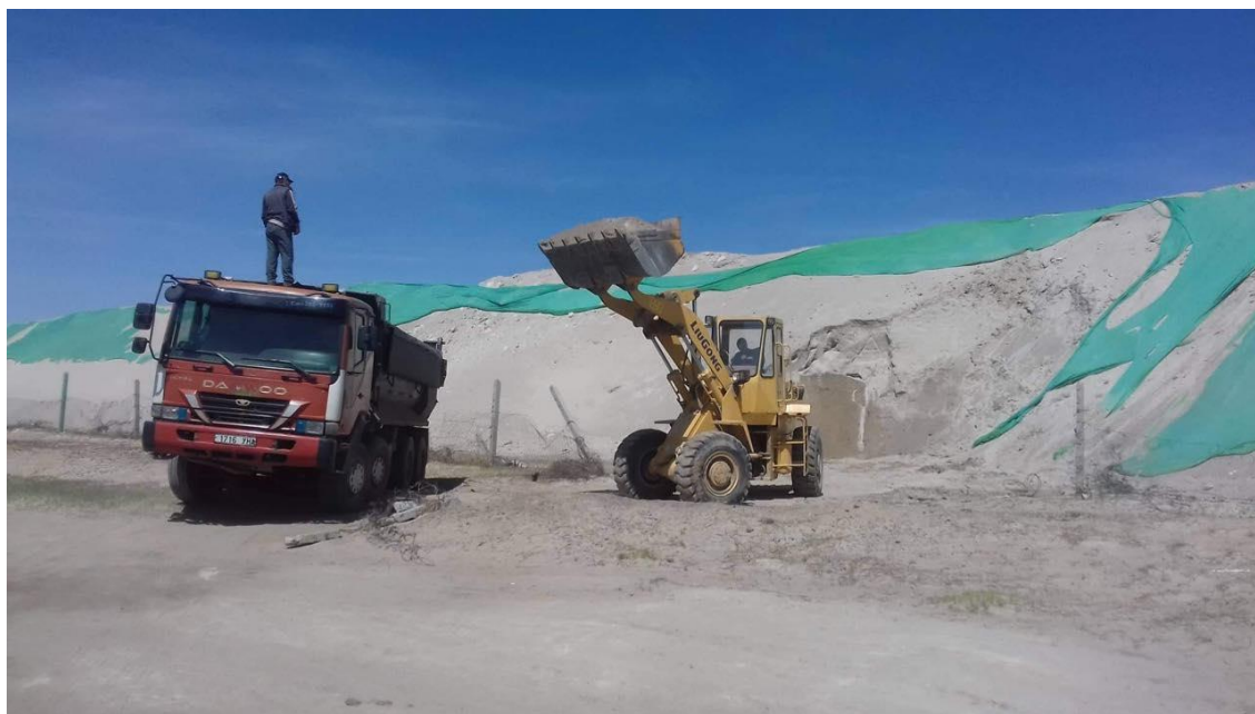
Зураг 7. Үнс хадгалах талбайн хучлагыг түр үнс ачиж буй байдал
