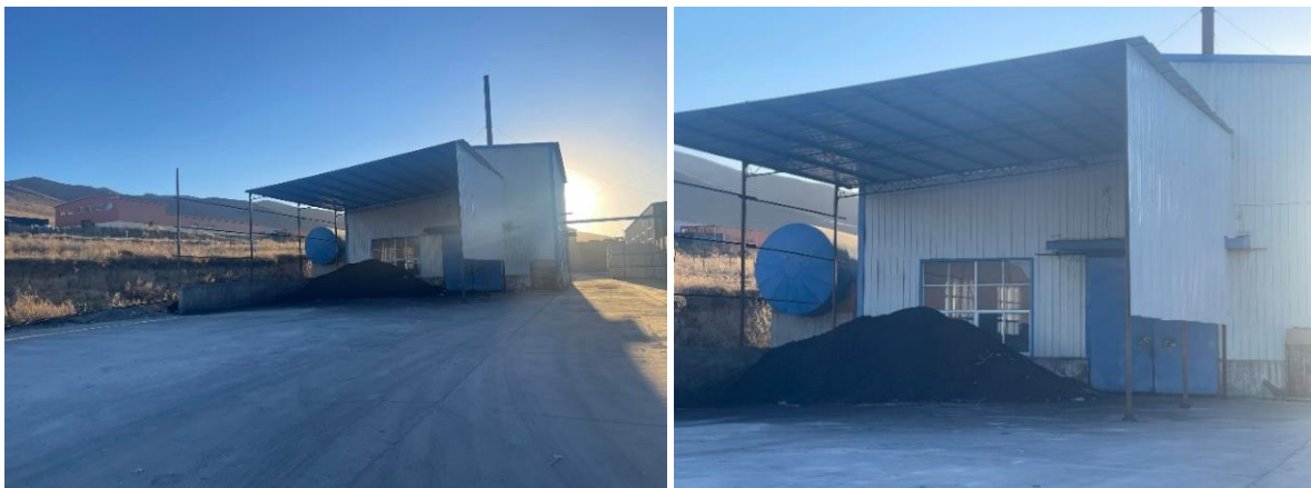
Зураг 6. Үйлвэрийн талбай дахь задгай түүхий эд хадгалах хэсэгт саравч байгуулсан нь
