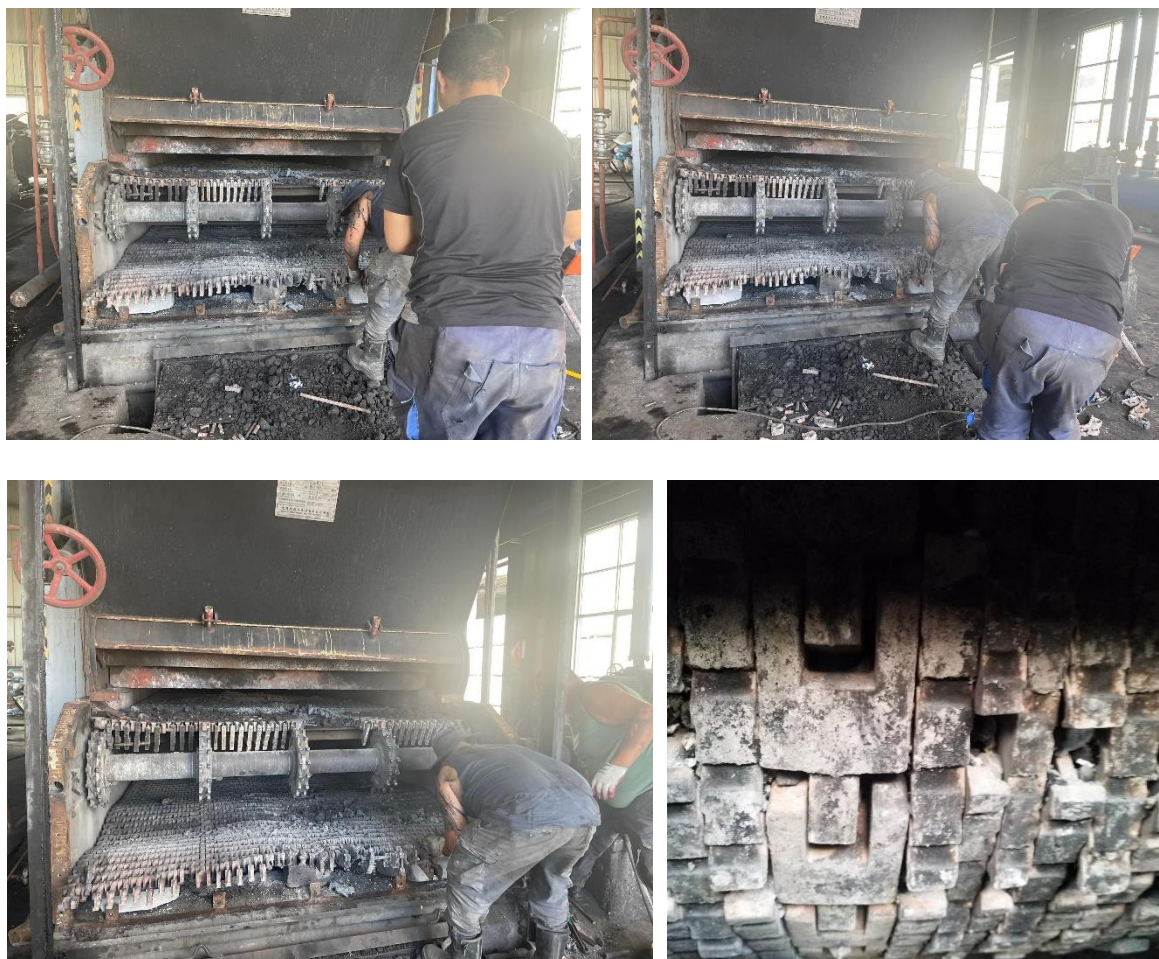
Зураг 11. Уурын зуухны үнсийг цэвэрлэх, ээлжит засвар үйлчилгээ хийж буй байдал
