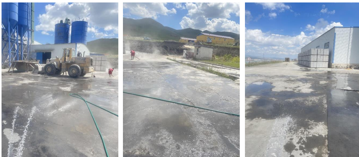
Зураг 8. Тоосжилттой үед үйлдвэрийн орчныг усалж чийгшүүлсэн байдал
