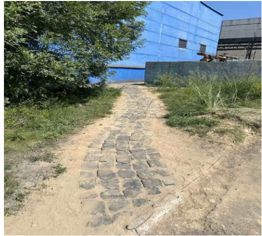
Зураг 2 Хаягдал тоосго ашиглан явган хүний зам хийсэн байдал
