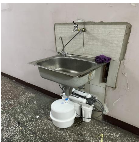
Зураг 5 Ус цэвэршүүлэх төхөөрөмж суурилуулсны дараах байдал
