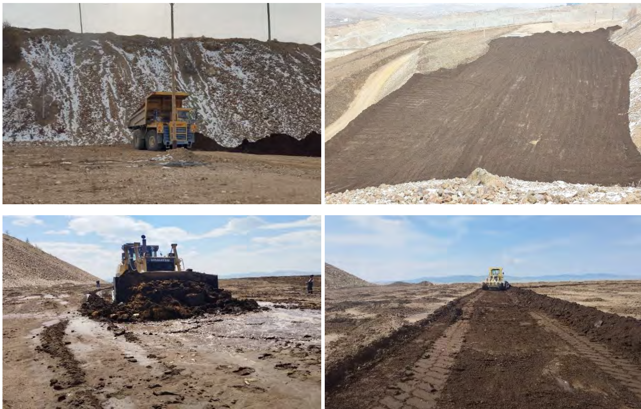
Зураг 69. Талбайд шимт хөрс буулгаж тэгшилсэн байдал
