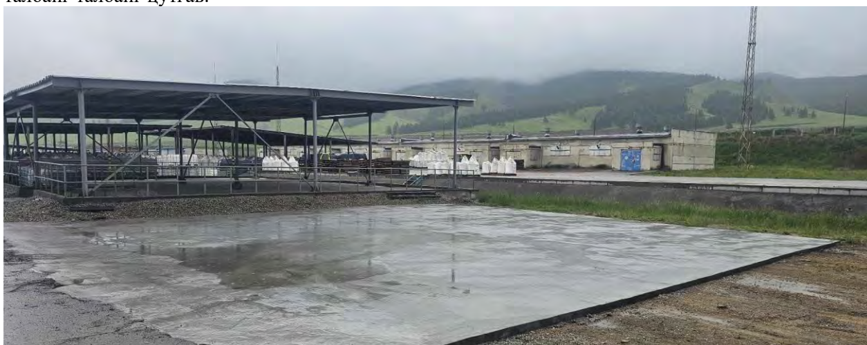
Зураг-6. ЭТБҮ-д химийн бодисын сав хураах зориулалт бүхий 20м*20м харьцаатай цементэн талбайг талбайг цутгав.
