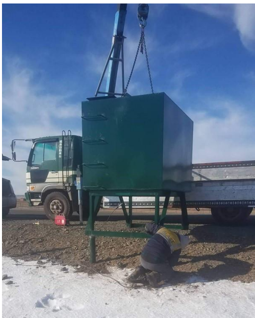
Усны савыг кранаар буулгаж байгаа болон хөлийг нь гагнаж буй байдал
