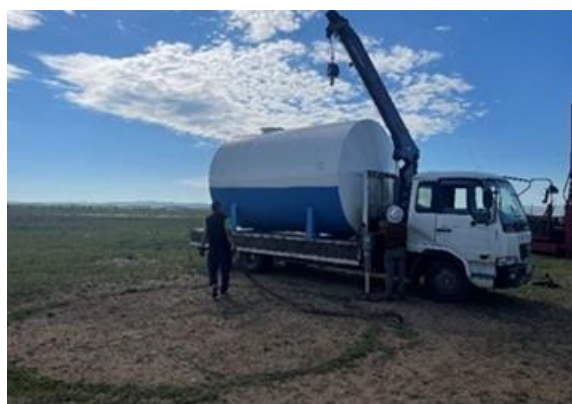
25 тн ёмкость талбайд байрлуулж байдал
