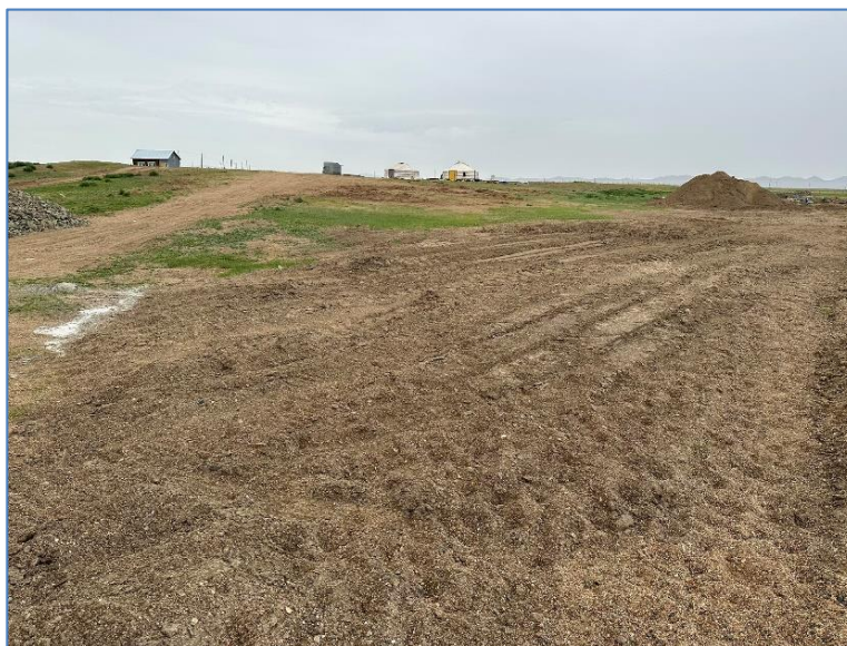
Зураг 10. Газар шорооны ажлын үед үүсгэсэн ухаш, овоолгыг тэгшилж, анхны төрхөнд нь оруулах буюу техникийн нөхөн сэргээлт хийж буй байдал
