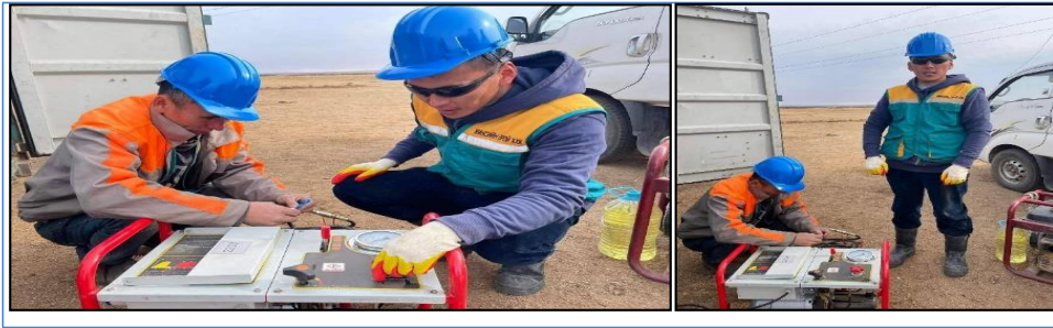
Зураг 23. Төслийн талбай дээр жижиг тоног төхөөрөмжийн засвар хийж буй ажлын явцаас
