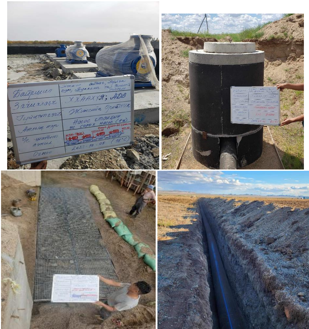
Зураг 3. Барилга угсралт, газар шорооны ажлын явцаас
