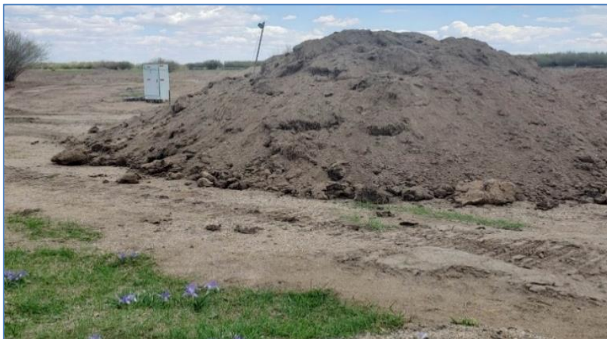
Зураг 12. Өнгөн хөрсийг тусгай талбайд хадгалж байгаа байдал
