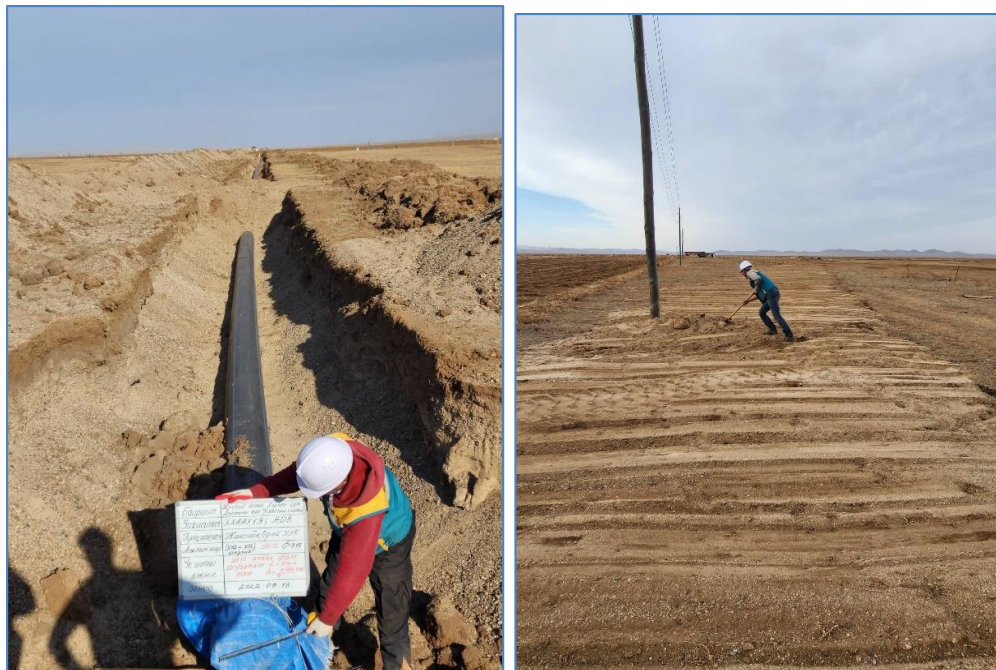
Зураг 14. Газар шорооны ажлын үед үүсгэсэн ухаш, овоолгыг тэгшилж, анхны төрхөнд нь оруулах буюу техникийн нөхөн сэргээлт хийж буй байдал
