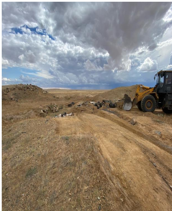
Хог хаягдлыг булж тэгшилж байгаа нь
