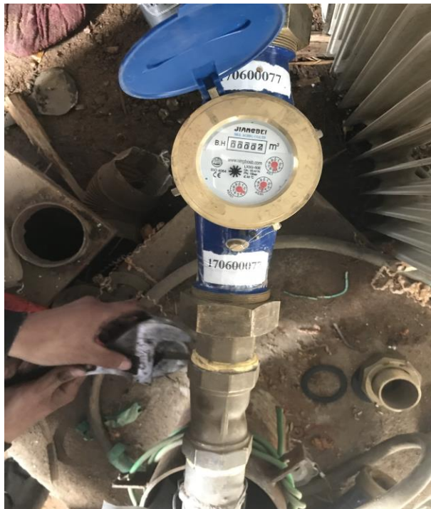
“Чандмань-Илч” ХХК-иар усны тоолуур солиулан баталгаажуулж байгаа нь
