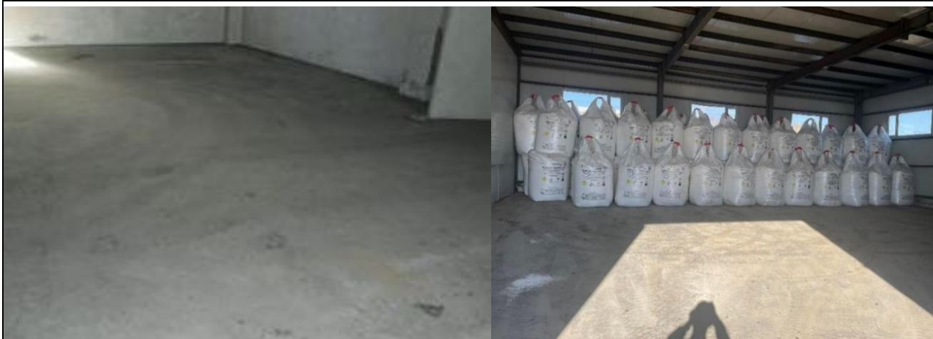
Зураг-35 Химийн бодисын агуулахын шалыг завсаргүй битүү бетондсон.
