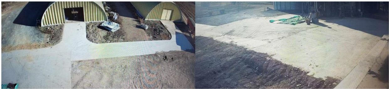
Зураг 3. Ажлын талбайг бетондож газрын гадарга хамгаалсан, тоосжилтоос сэргийлсэн
