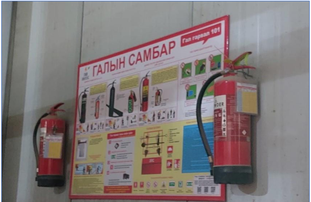
Зураг 14. Гал унтраах иж бүрдэл, галын мэдрэгч байрлуулсан байдал
